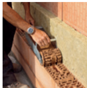
Les murs mitoyens séparant les sept habitations ont été totalement dédoublés.
