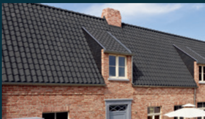
>Toit: Koramic OVH Klassiek Bleu fumé, Façade: Terca Belle Epoque de Mons - Architecte J. Pattyn en collaboration avec P&L Woningbouw, Wevelgem
