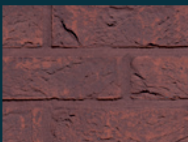
Joint ton sur ton
